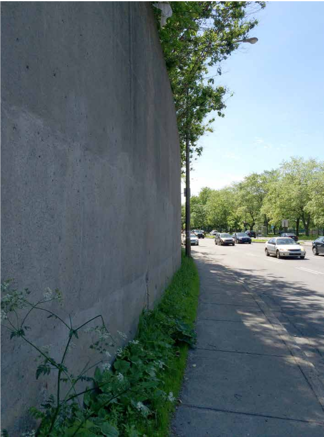
Perception progressive du mur, direction nord
