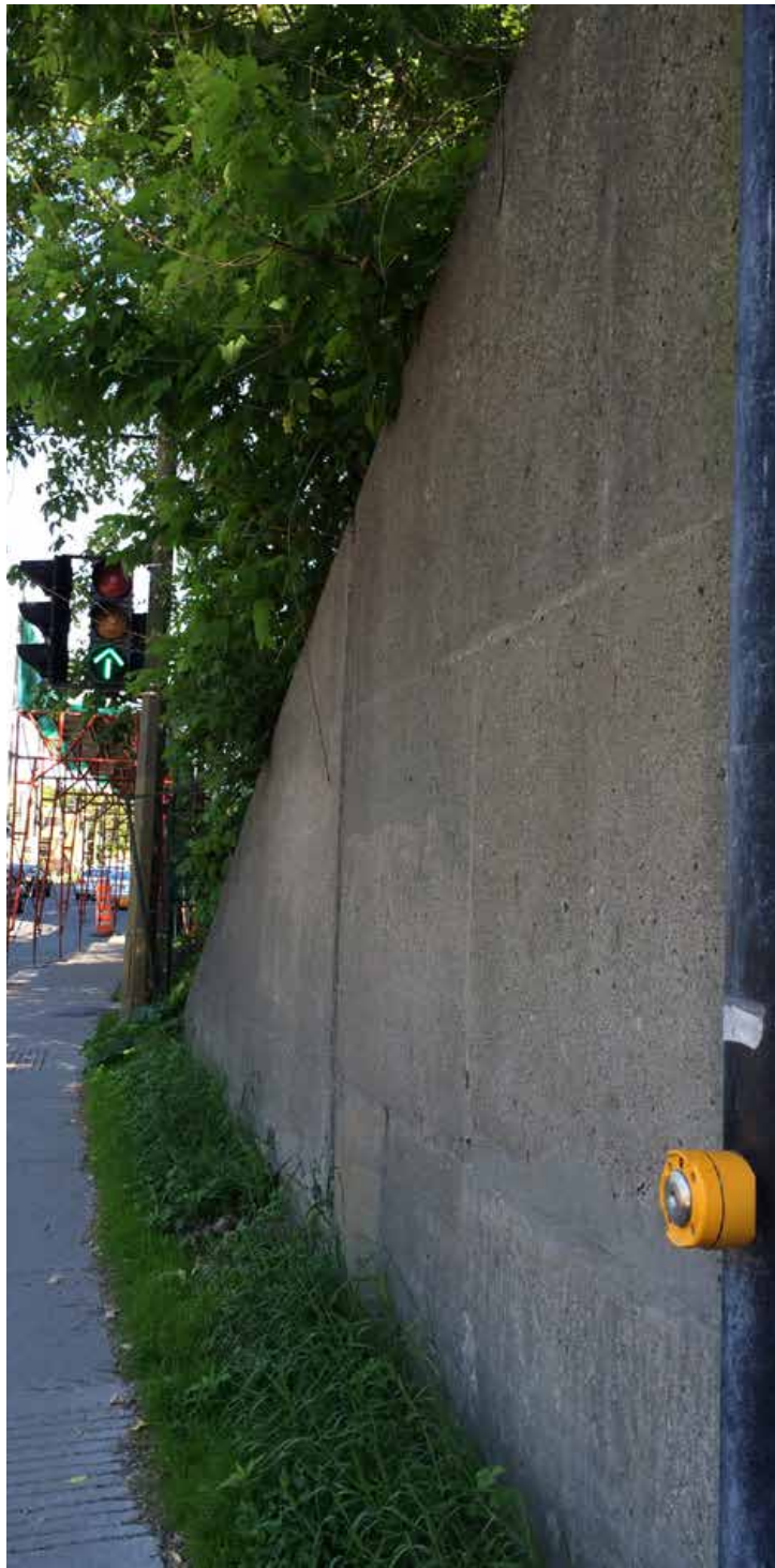
Perception progressive du mur, direction sud
