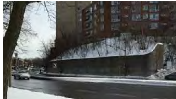
Mur de soutènement en béton
