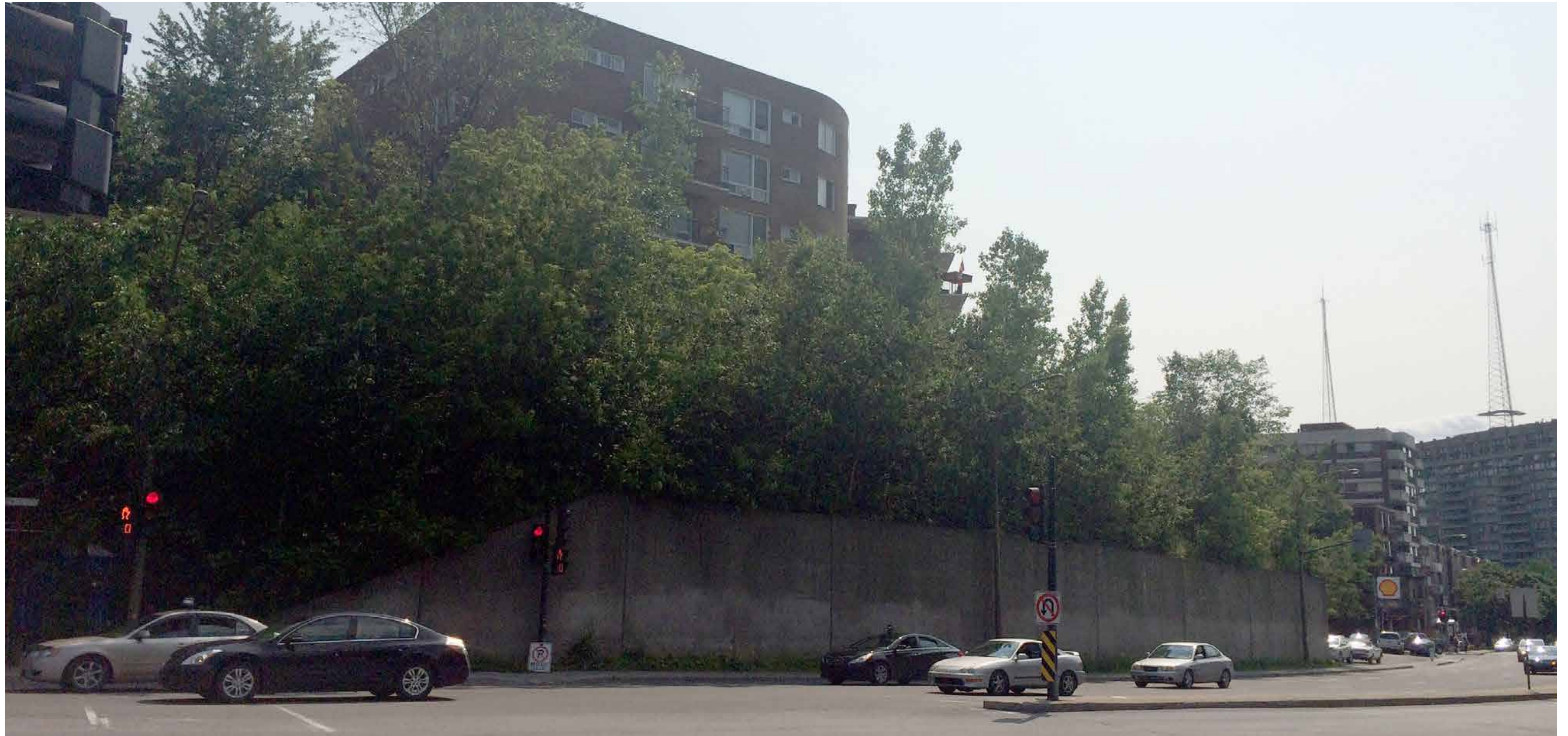
Vue d'ensemble du mur visé, à partir du trottoir opposé
