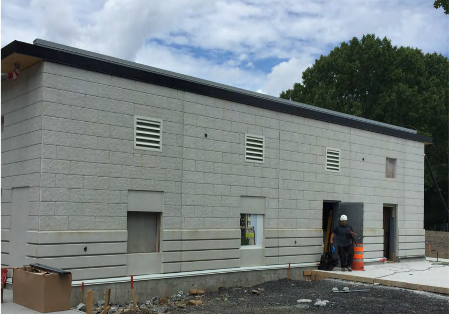
Image du bâtiment en cours de construction
